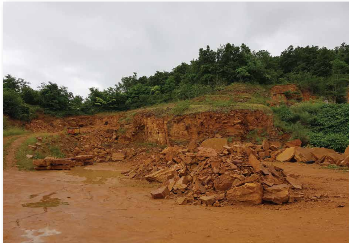
Photo 3 : Vue des fronts d'exploitation actuels et de la rampe d'accès
