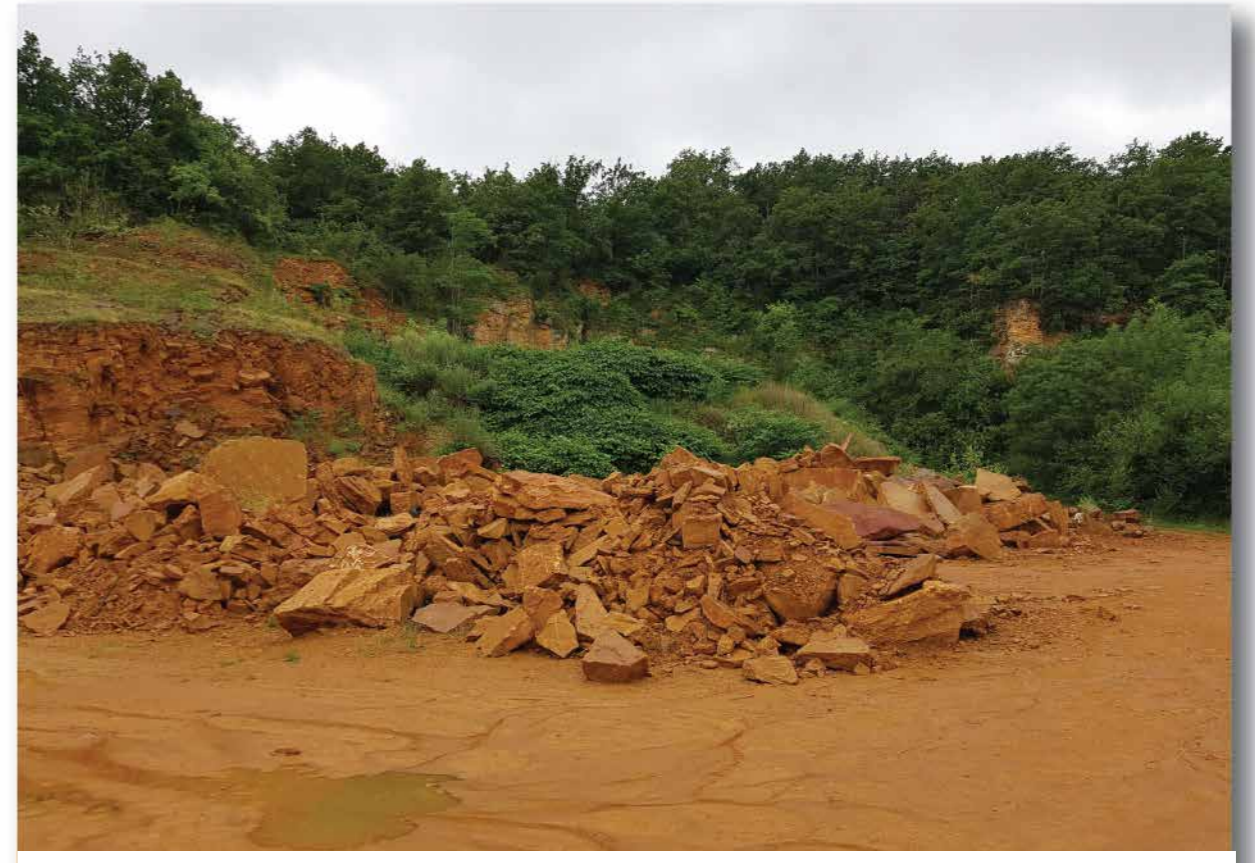
Photo 2 : Vue des stocks et de la zone en cours de remblaiement et remise en état
